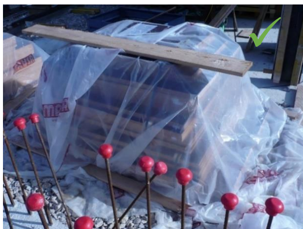
Fig. 5. Tableros protegidos en obra
