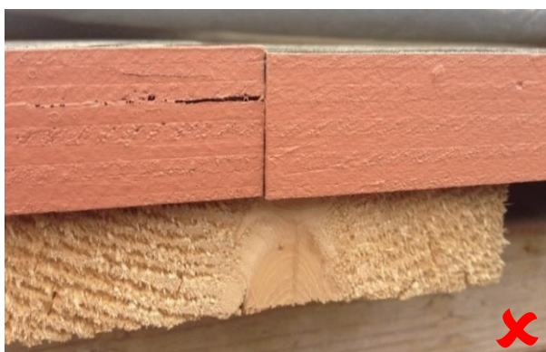
Fig. 8. Bastidor construido con madera no tratada y sin margen de separación entre tableros
